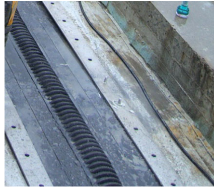
Bild 6. Ausschnitt: Rillenfugenbad für 3-axiale Bewegung
