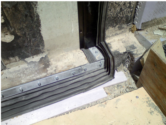
Bild 8. Außenseitiges Klemmfugenband aus Nitrilkautschuk
