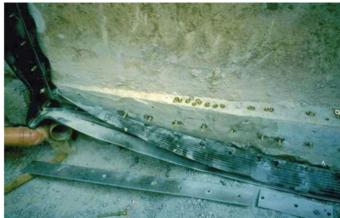
Bild 9. Innenliegendes Klemmfugenband, Setzen der Ankerstäbe
