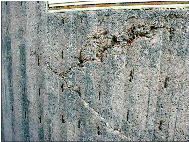
Foto 4: Beton Verdichtungsbild im Fensterbereich
